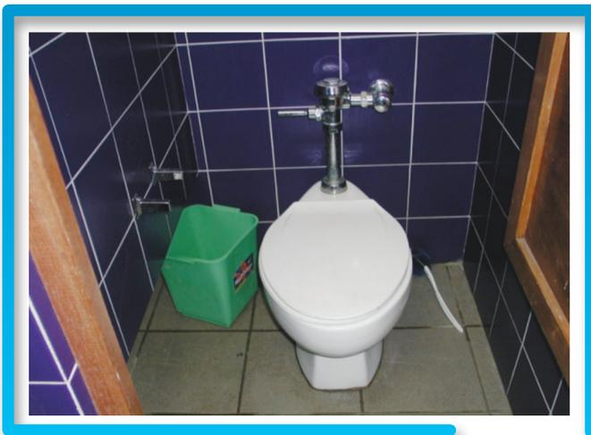
Fotografía No. 16: Servicio sanitario con válvula temporizada tipo fluxómetro en Escuela Omar Dengo
