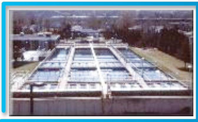
Fotografía No. 2: Batería de sedimentadores rectangulares
