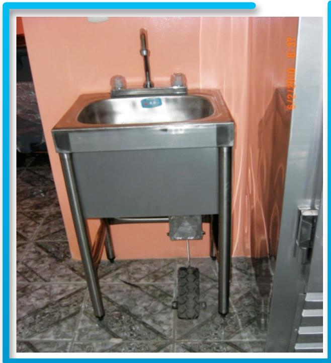
**Fotografía No. 19: Uso de nuevas pilas y dispositivos automáticos ahorradores de agua, instalados en la Escuela Concepción de Alajuelita**
