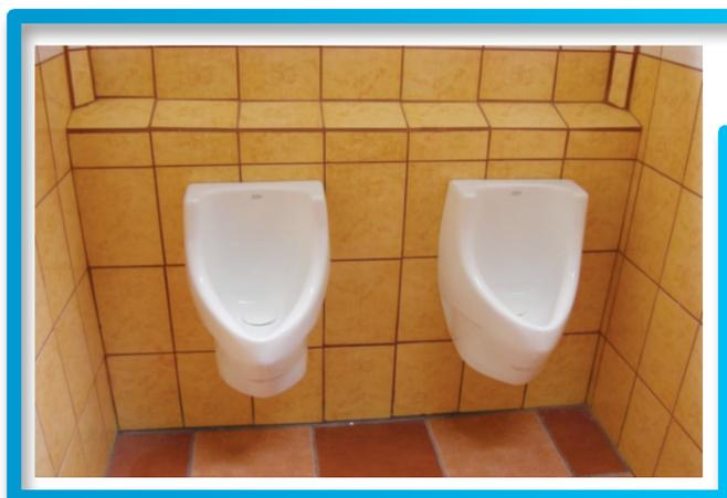
Fotografía No. 12: Orinal tipo mingitorio “water free”, Escuela Juan E. Pestalozzi Antes orinal tipo “cascada”
