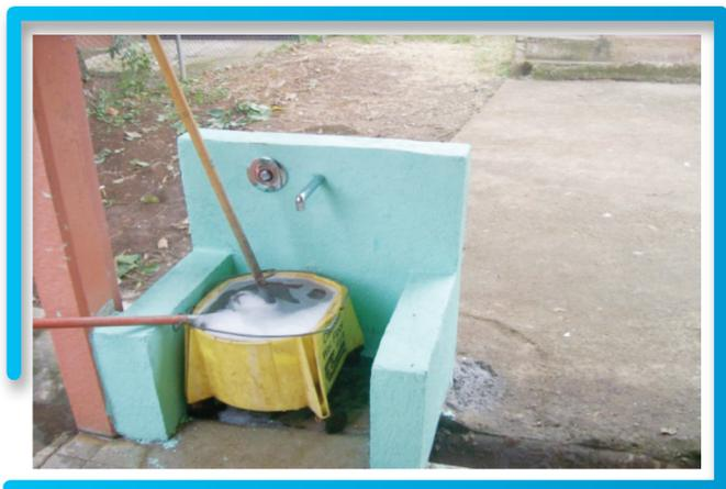
Fotografía No. 15: Pileta para limpieza de trapo piso, con válvula automática, en Escuela Maiquetía
