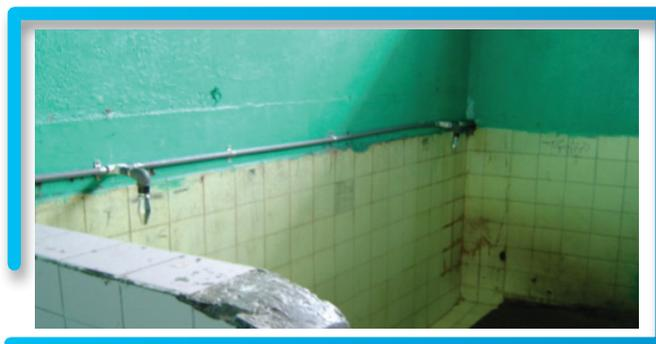
**Fotografía No. 3:** Aplicación de válvulas fordillas en orinal tipo “cascada”
