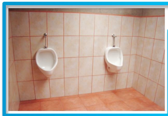
Fotografía No. 13: Orinal con válvula temporizada, Escuela Betania. Una nueva construcción
