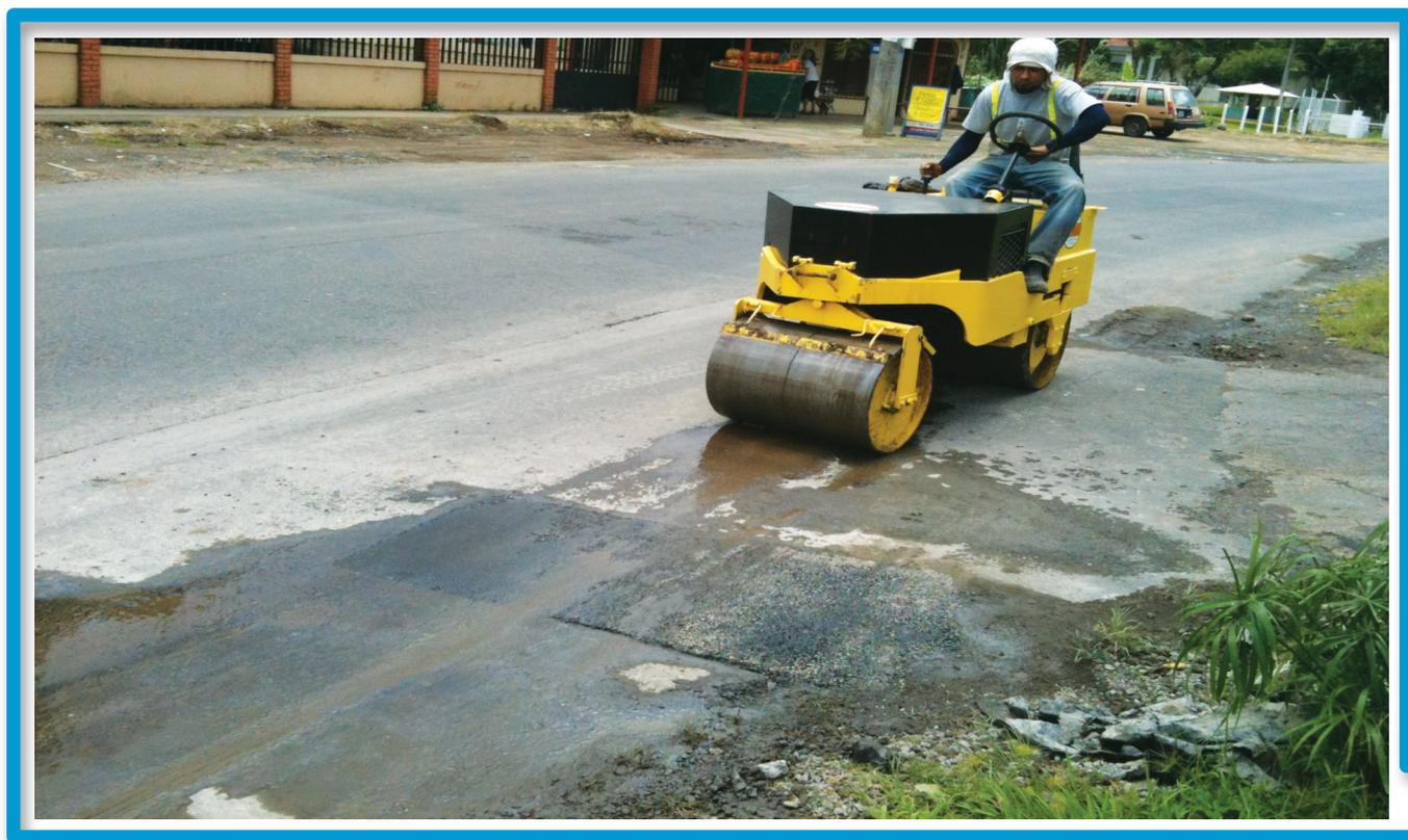
Fotografía No. 9: Reparación de asfalto posterior a la sustitución de Tubería
