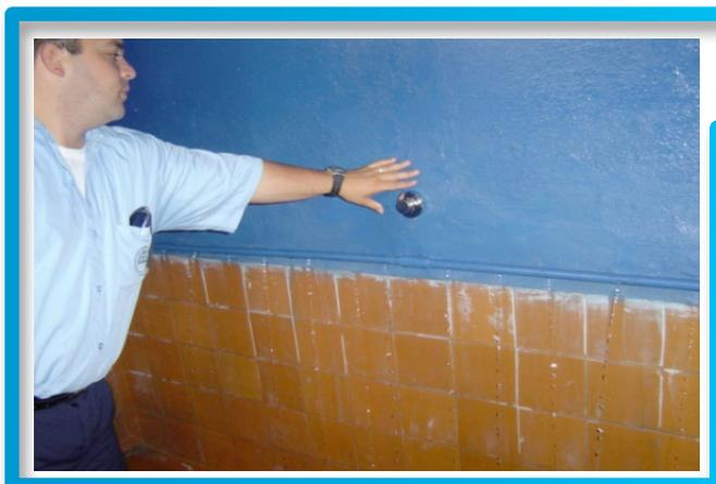
Fotografía No. 7: Orinal tipo “cascada” operado con válvula temporizada instalada con la mejora. Automatización en el abastecimiento de agua en la pila del comedor estudiantil de la Escuela República de Haití, las figuras No 8 y 9 muestran detalles
