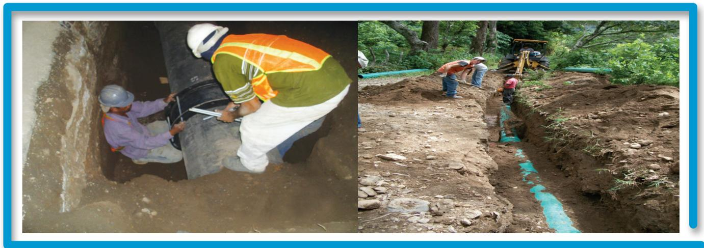
Fotografía No. 8: Sustitución de tubería
