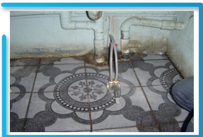
Fotografía No. 8: Válvula temporizada automática bajo el fregadero
