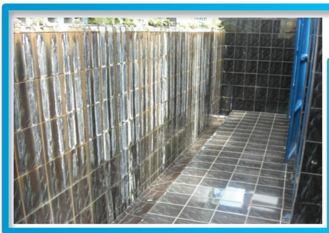
**Fotografía No. 10: Orinal tipo “cascada” de la Escuela Central de San Sebastián, se aprecian incrustaciones de Carbonato de Calcio en la pared (manchas claras), que evidencian consumo permanente de agua**
